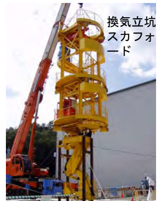
施工状況 (坑口部 GL-51.0m)
